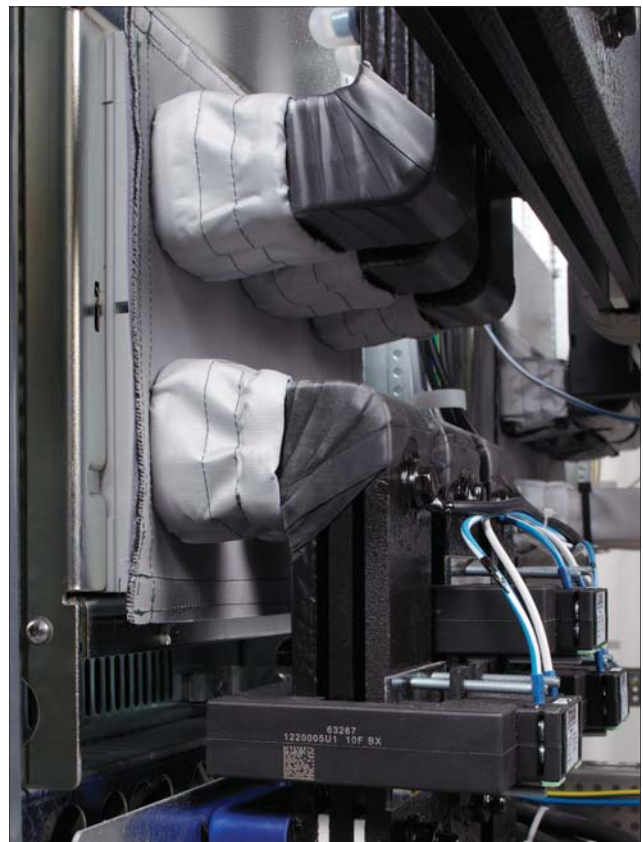
Feldrückseite Kuppelschalter: Schienen beschichtet, Schalteranschlüsse isoliert
