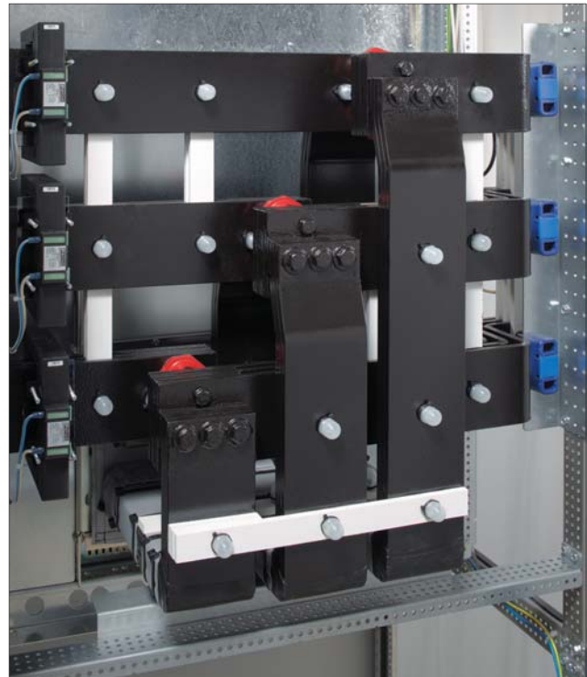
Feldrückseite Kuppelschalter: Schienen beschichtet, Schalteranschlüsse isoliert
