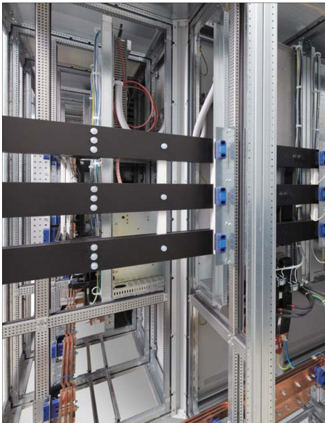
Schaltanlage mit offener Rückseite, Hauptsammelschiene beschichtet
