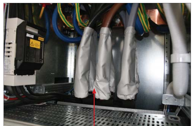
Detail Kabelanschluss voll isoliert
