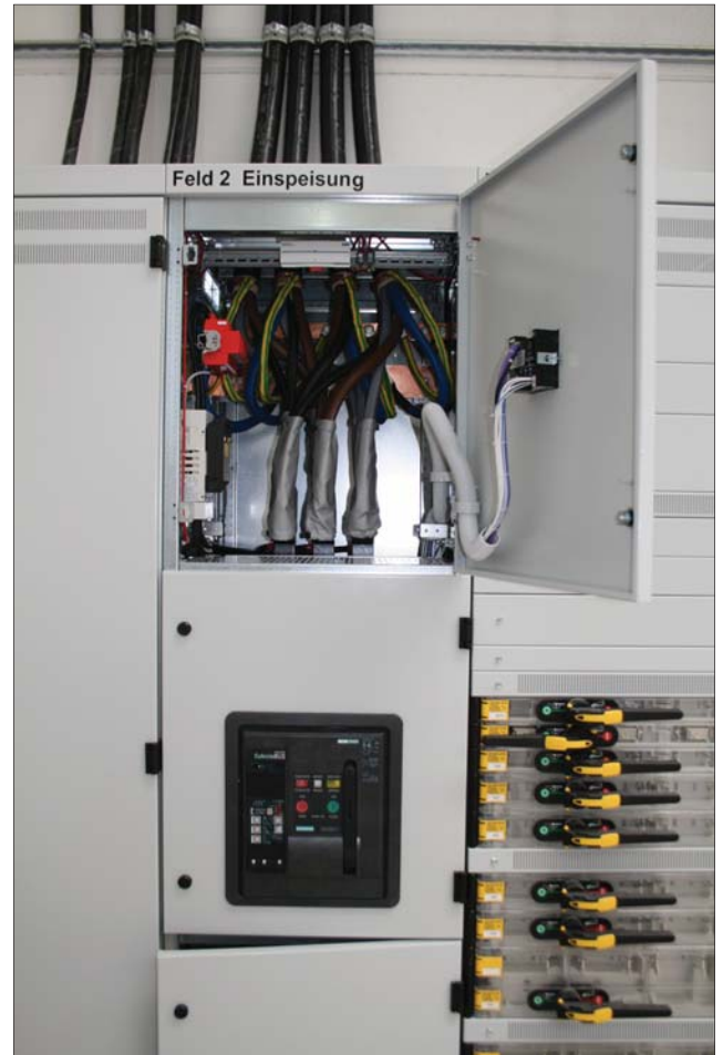
Einspeisefeld 4 Parallelkabel 240mm 2 , Kabelanschluss voll isoliert
